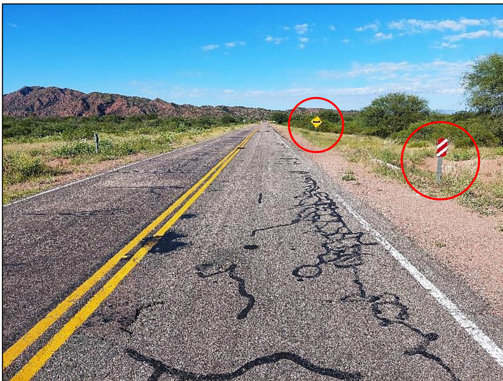
Figura 6. Vista panorámica del Vehículo 1. Se puede apreciar el estado de la carpeta asfáltica y la señalización horizontal. A la derecha de la imagen: un panel preventivo y luego un cartel preventivo de depresión transversal (badén) ubicado a 200 metros del inicio del cruce entre la ruta y el cauce. Fuente: JST, 2022.
