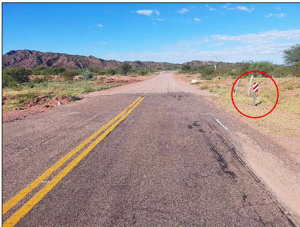
Figura 9. Vista panorámica del Vehículo 1. A la derecha de la imagen, un panel preventivo. Luego, el fin de la ruta asfaltada e inicio de ruta de hormigón en el cruce con el cauce. Fuente: JST, 2022
