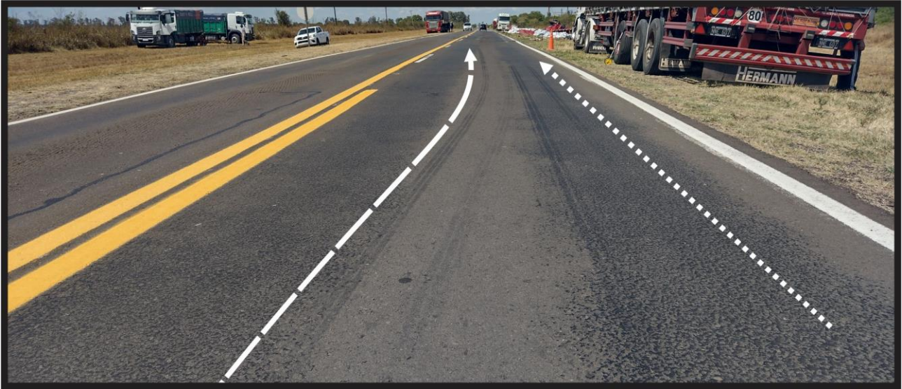
Figura 6. Rastros de neumático detectados sobre el carril sur de la ruta, cuyas proyecciones cruzaron junto a la finalización de la demarcación horizontal consistente en doble línea amarilla central. Fuente: JST, 2022.
