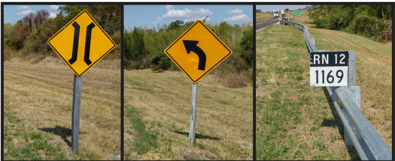
Figura 4. Señales verticales verificadas según su orden de aparición e instaladas sobre el margen sur de la ruta para los vehículos que se desplazan con sentido hacia la ciudad de Posadas: 1) Preventiva de puente, 2) Preventiva de curva a la izquierda, y 3) Informativa del kilómetro 1169. Fuente: JST, 2022.
