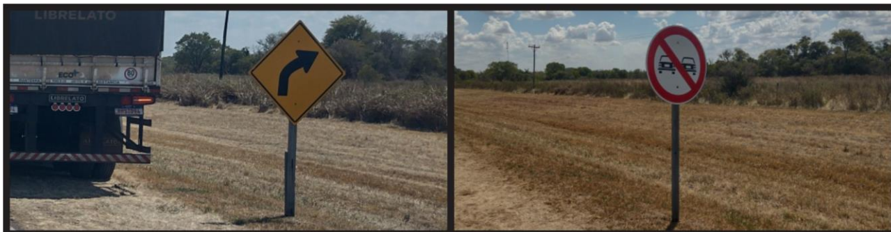
Figura 5. Señales verticales verificadas según su orden de aparición e instaladas sobre el margen norte de la ruta para los vehículos que se desplazan con sentido hacia la ciudad de Corrientes: 1) Preventiva de curva a la derecha, 2) Reglamentaria de prohibición de adelantamientos. Fuente: JST, 2022.
