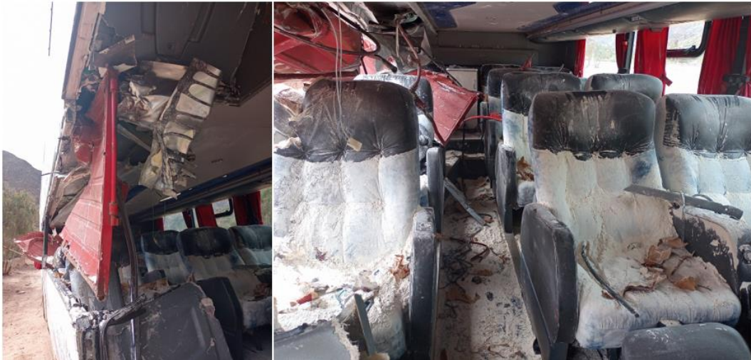
Figura 17. Vista de la zona del impacto en el lateral derecho del ómnibus. Fuente: JST, 2022
