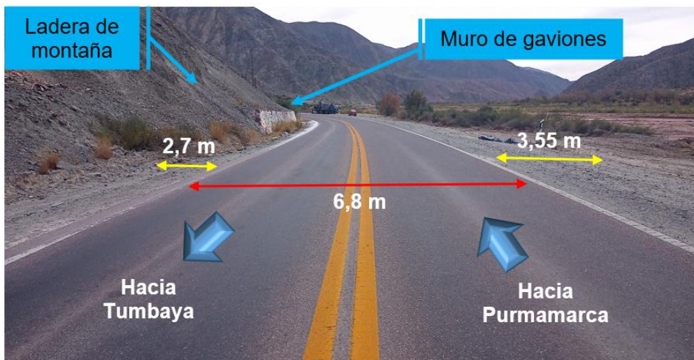
Figura 3. Dimensiones y estado de la vía en la zona próxima al impacto en sentido sur-norte. Fuente: JST, 2022
