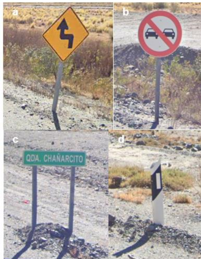
Figura 6. Señalización vertical observada en el lugar del suceso. Fuente: JST, 2022
