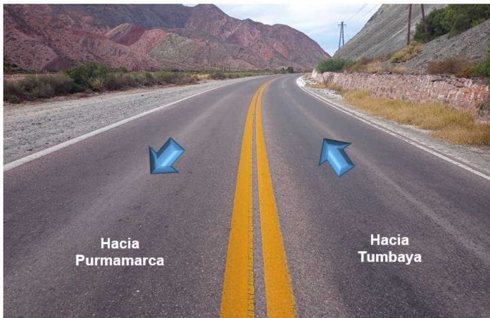
Figura 5. Características y estado de la vía en sentido norte-sur. Fuente: JST, 2022
