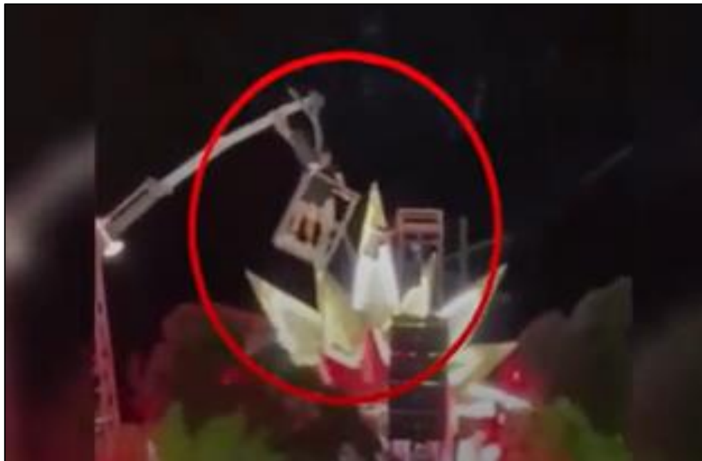
Figura 14. Secuencia del desprendimiento de la guindola (editado por la fuente periodística)
