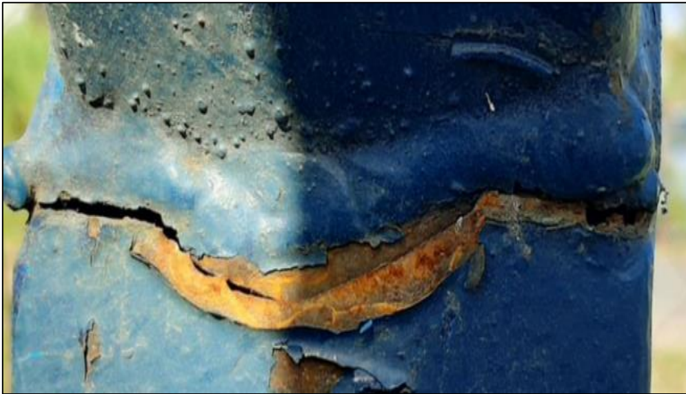
Figura 3. Cordón de soldadura del brazo del canasto
