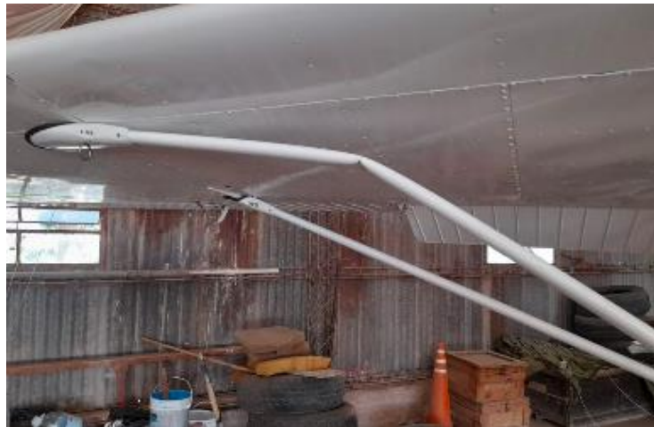
Figura 5. Daños en el montante del lado derecho del ala
