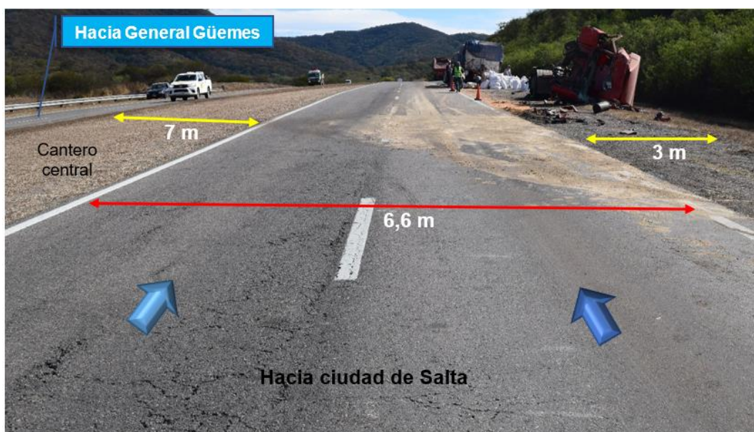
Figura 3. Dimensiones y estado de la vía en la calzada con sentido este-oeste y en proximidades a la zona de impacto. Fuente: JST, 2022
