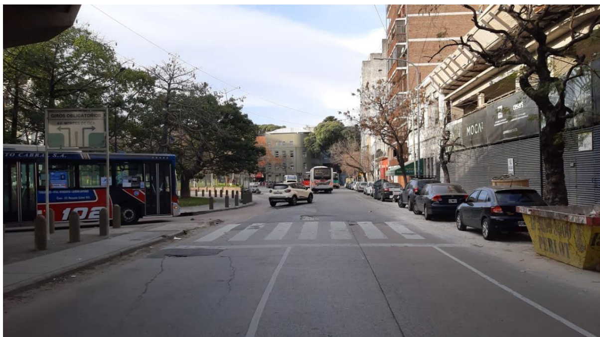
Figura 4. Intersección a bajo nivel de la Avenida Dr. Enrique Finochietto y Au. Presidente Arturo Frondizi. Fuente: JST, 2022
