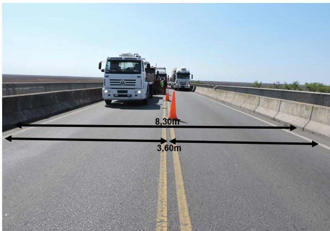
Figura 3. Dimensiones sobre el puente donde se produjo el suceso. Fuente: JST, 2022
