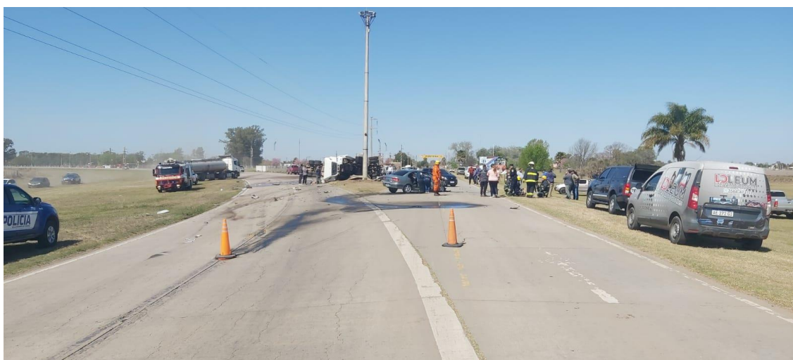
Figura 6. Señalización horizontal ilegible sobre Av. 25 de mayo y RP 1. Fuente: JST, 2022
