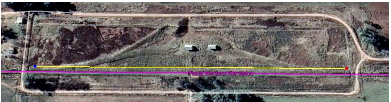
Figura 5. La línea amarilla indica la posición de la formación al momento de la detención producto del descarrilamiento. Fuente: Google Earth, anotaciones JST
