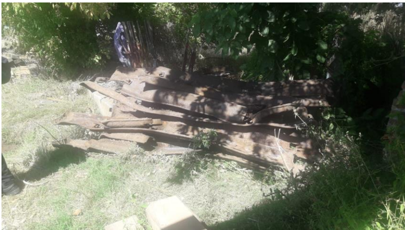
Figura 9. Durmientes metálicos afectados por el descarrilamiento. Fuente: Investigadores JST
