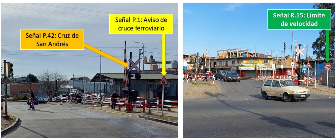
Figura 14. Señalización pasiva presente actualmente en la zona del paso a nivel Del Tejar. Fuente: investigadores JST, 2022
