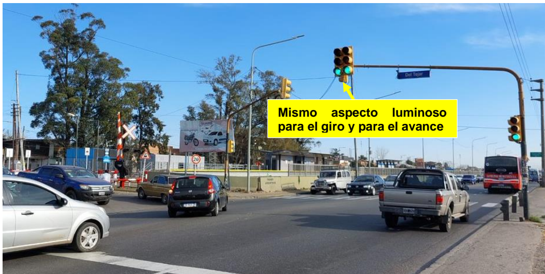
Figura 16. Imagen del semáforo de la RP 21 con el mismo aspecto luminoso, tanto para la habilitación del giro hacia el paso a nivel Del Tejar, como para el avance vehicular en sentido a González Catán. Fuente: investigadores JST, 2022
