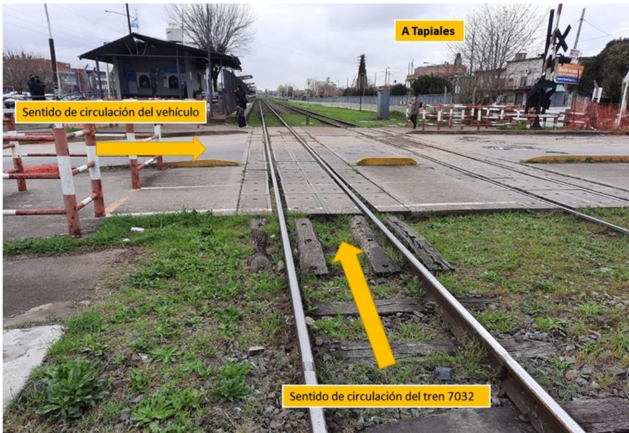
Figura 1. Paso a nivel Del Tejar, vista en sentido a la estación Tapiales. Fuente: investigadores JST, 2021
