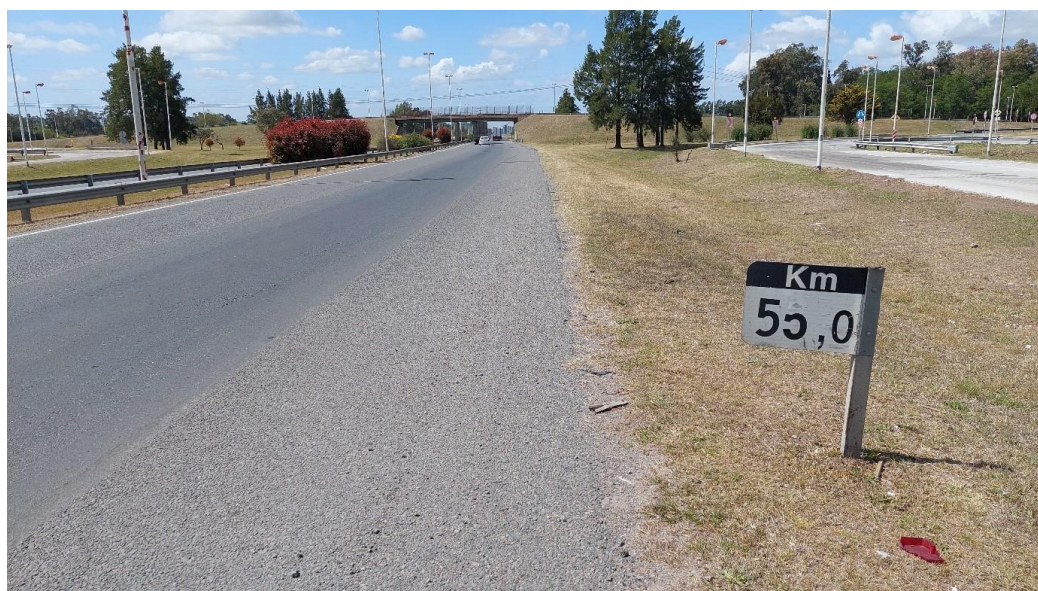
Figura 4. Indicador del kilómetro 55 ubicado a 260 m hacia la localidad Cañuelas desde el inicio de las huellas y vestigios. Fuente: JST, 2022
