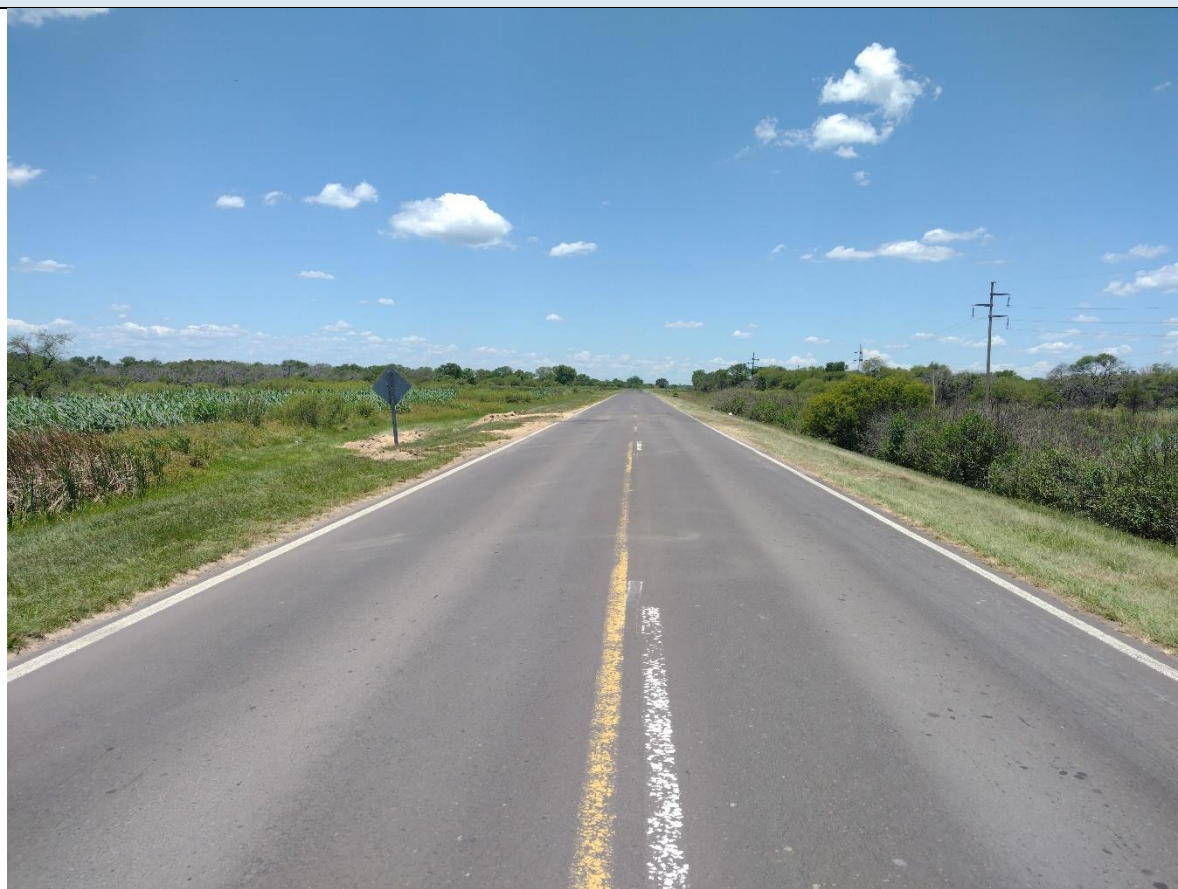
Figura 1. Vista del tramo de la ruta donde se desarrolló el siniestro. Fuente: JST, 2022
