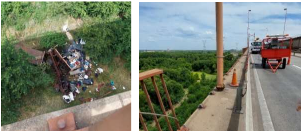
Figura 1. Posición final del Vehículo 1 y daños a la vía. Fuente: JST, 2022
