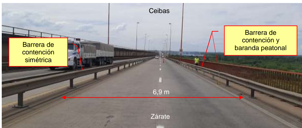
Figura 3. Características de la vía donde se produjo el despiste. Fuente: JST, 2022
