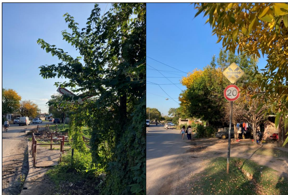
Figura 17. Señalización pasiva vertical obstaculizada por vegetación. Fuente: JST,2023
