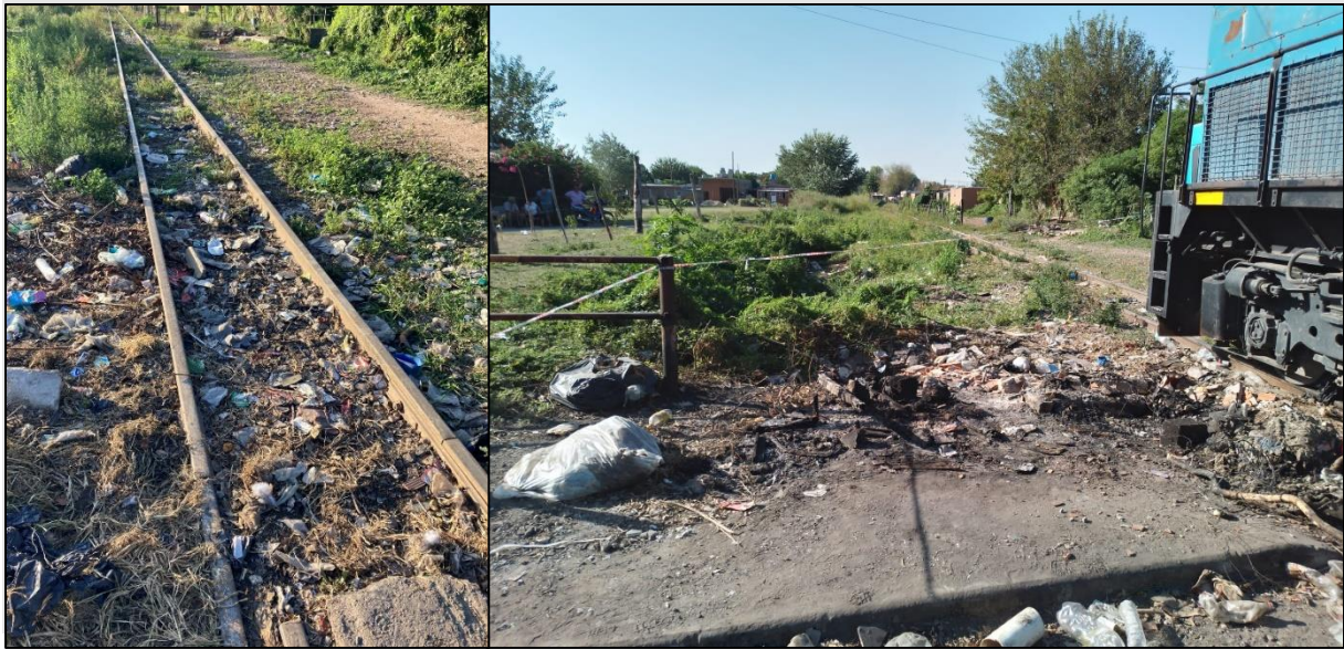
Figura 10. Presencia de residuos en zona de vía. Fuente: JST, abril 2023
