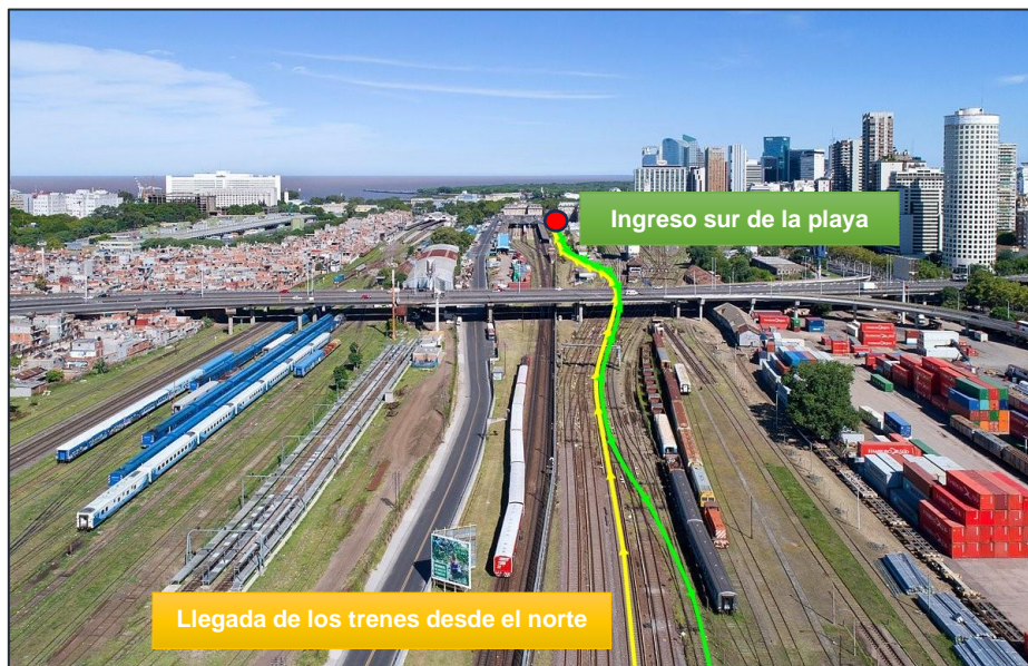
Figura 12. Imagen donde se observa el sentido de arribo de los trenes desde el norte (amarillo) y su ingreso a la playa Retiro Cargas por el sur (verde). Fuente: Rail Pitures.Net
