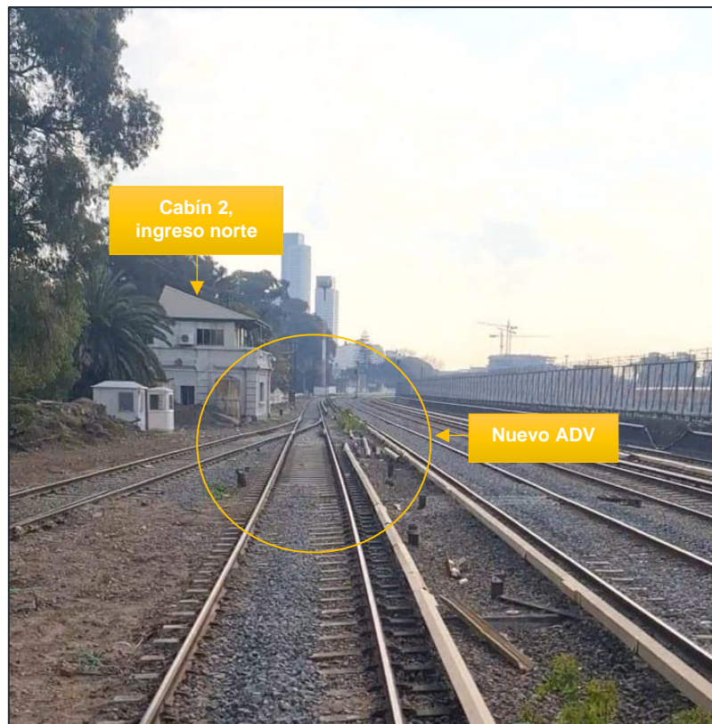
Figura 17. Imagen del nuevo aparato de vía (ADV) instalado en Cabín 2. Fuente, JST, 2023
