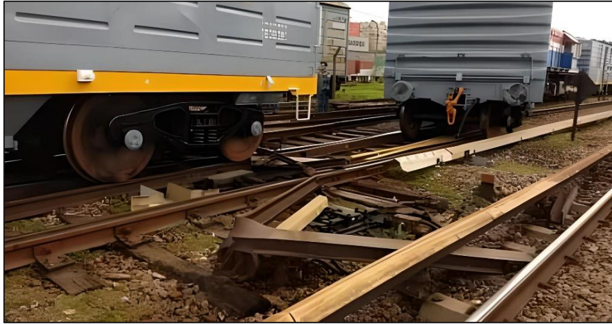
Figura 15. Descarrilamiento de formación de carga de la empresa NCA en la playa Retiro Cargas, ocurrido el 31 de agosto de 2020. Fuente: Crónica Ferroviaria
