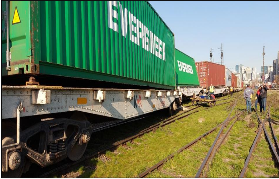
Figura 4. Vista general del tren de carga OP 9502/085 impactado por la locomotora 8258. Fuente: JST, 2021
