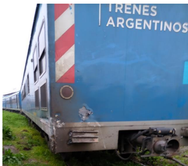
Figura 11. Daños en coche FU5009 de la formación N°1 ubicada en la vía N.º 5. Fuente: JST,2021
