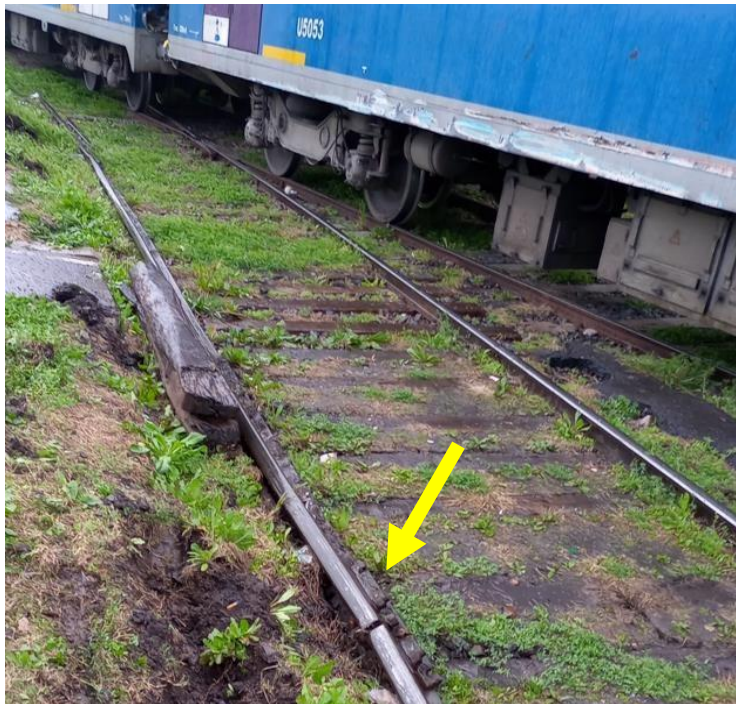
Figura 9. Vuelco de riel opuesto al choque (izquierda de la figura). Fuente: investigadores JST, 2021
