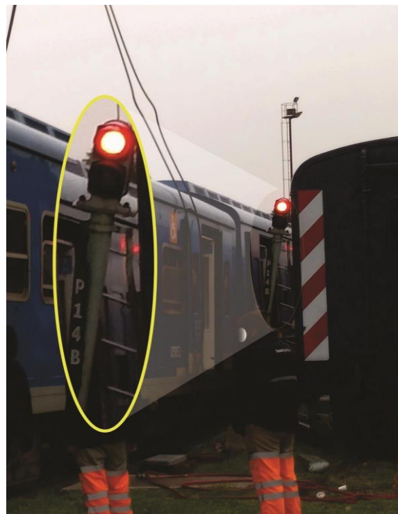
Figura 10. Inclinación de la señal P14B. Fuente: JST, 2021
