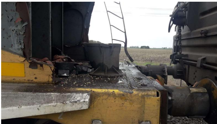
Figura 1. Daños en elementos de tracción y choque de uno de los vagones involucrados en el accidente.
