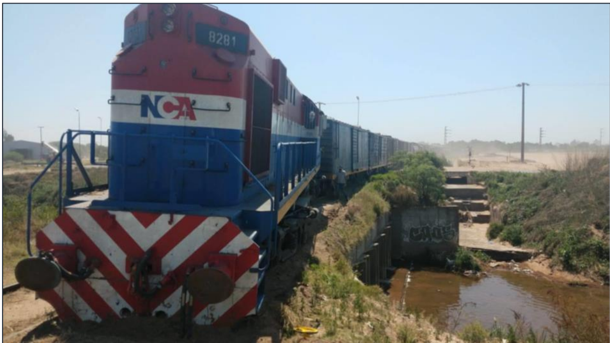
Figura 1. Tren 110/496 descarrilado sobre una alcantarilla ferroviaria. Fuente: JST, 2021
