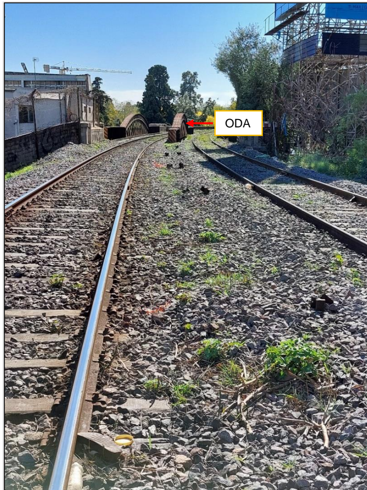
Figura 5. Curva cercana al suceso en sentido a la estación Retiro. Fuente: JST, 2022
