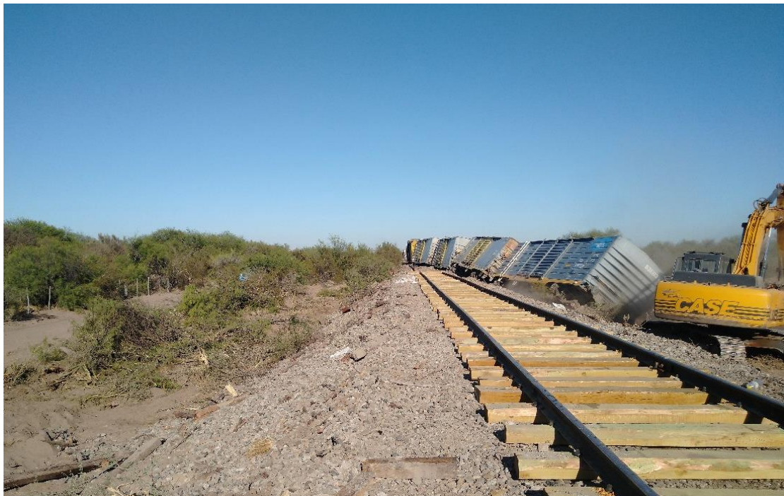
Figura 2. Reacondicionamiento de la superestructura vía. Fuente: JST, 2023
