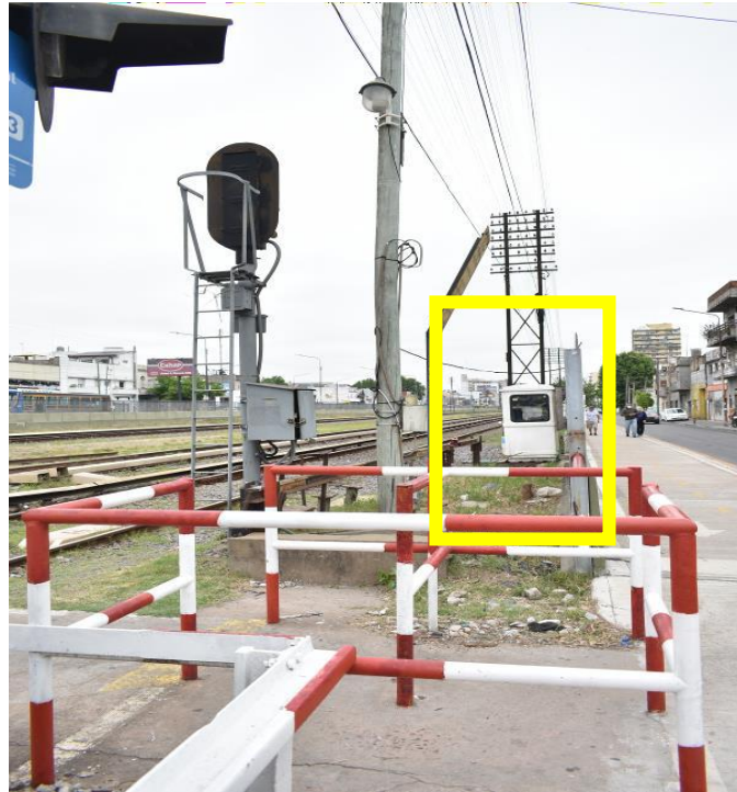
Figura 3 – Los peatones tienen una escasa visibilidad ya que aproximadamente a 6 Mts del paso peatonal se encuentra una garita que interfiere en la visualización de la formación, cuando circula de forma descendente (Av. Maipú).
