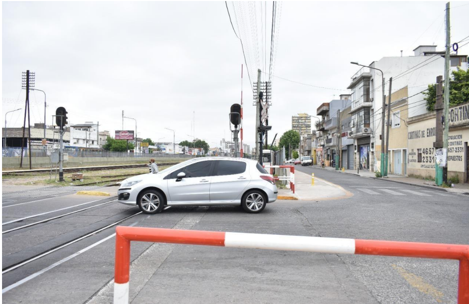
Figura 12- No existe señalización pasiva vertical ni horizontal en ambas arterias de acceso vehicular que advierta a los conductores y/o peatones sobre la proximidad del paso a nivel.
