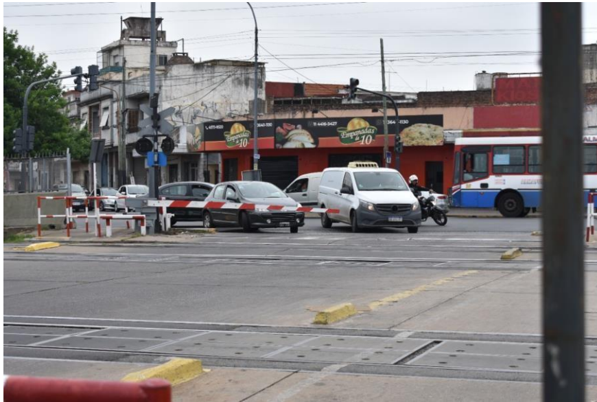
Figura 2 – Los vehículos quedan posicionados a 45°, dado que la distancia entre el cerramiento y la calzada es de 1.05 Mts, el cual reduce significativamente la maniobra de giro hacia el paso a nivel, dicha posición imposibilita ver la aproximación de una formación, dado que el sentido de circulación es el mismo en el que circulan los vehículos antes de ingresar al PAN.
