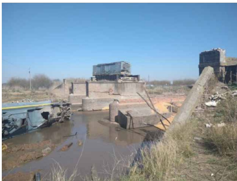
ILUSTRACIÓN 18. DESMORONAMIENTO DE PUENTE CON DESCARRILAMIENTO – 14 DE AGOSTO DE 2020 (BAJO INVESTIGACIÓN).
