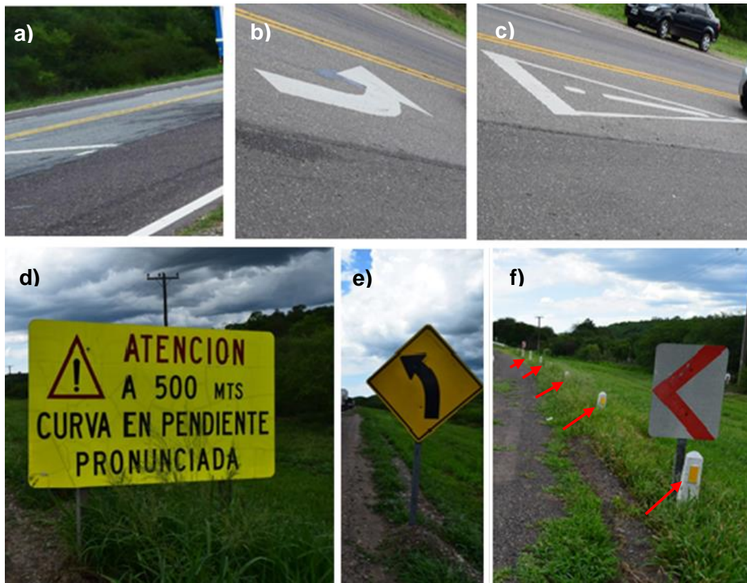
Figura 4. Señalización horizontal y vertical documentada en el tramo del sitio del suceso con sentido sur a norte: a) Líneas para reducción de velocidad sobre el carril rápido de progresiva sur-norte; b) Demarcación horizontal que indica “curva amplia a la izquierda”, c) Demarcación horizontal que indica “atención”; d) Cartel preventivo de “curva amplia a la izquierda”; e) Cartel preventivo de proximidad de curva peligrosa; y f) Paneles de prevención simples y postes reflectivos. Fuente: JST, 2023
