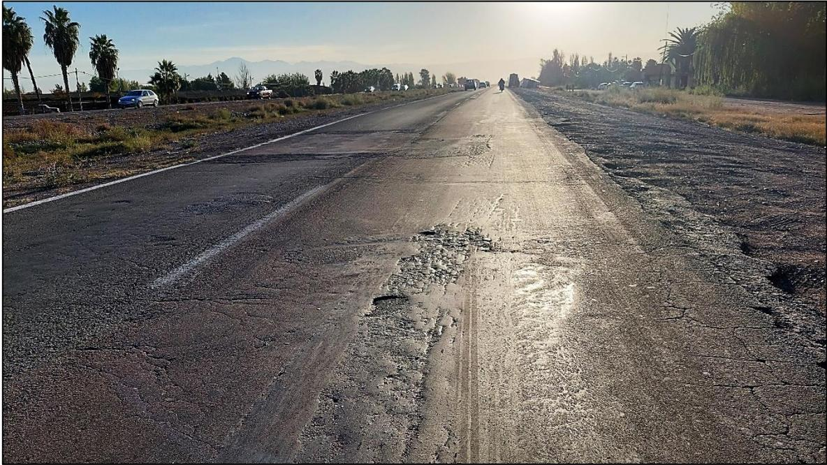
Figura 2. Vista general de la Ruta Nacional 7 hacia Mendoza (este a oeste). Sector con fallas en el pavimento asfáltico, próximo a la zona hipotética de pérdida de control del rodado. Fuente: JST, 2023
