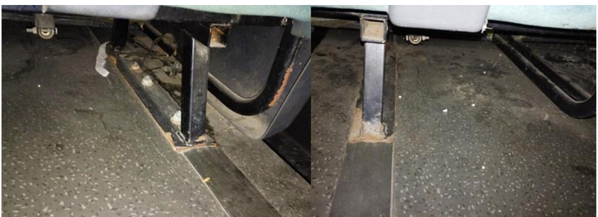
Figura 11. Detalle de anclaje de las butacas del Vehículo 2 donde se puede observar óxido y rastros de soldadura. Fuente: JST, 2023
