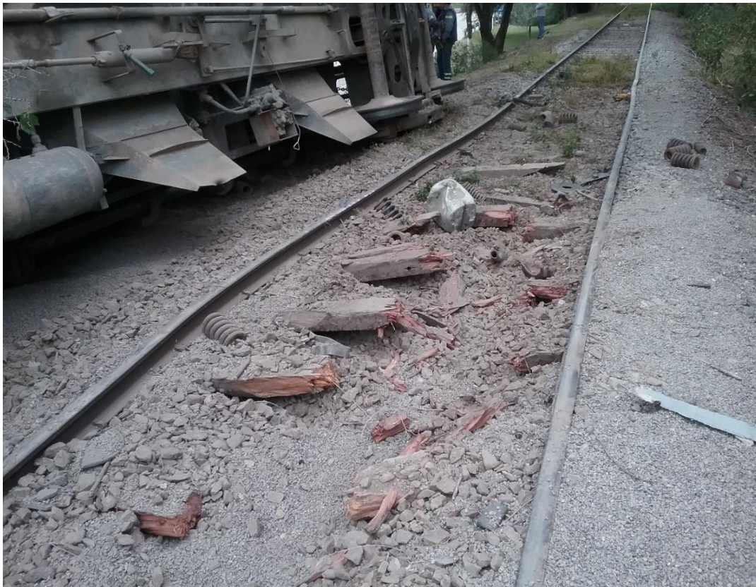
Figura 3. Durmientes de madera dañados y piezas de suspensión dispersas sobre la vía. JST, 2023
