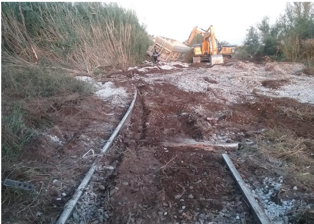
Figura 2. Trabajos de encarrilamiento y reacondicionamiento de vía. Fuente: JST, 2023
