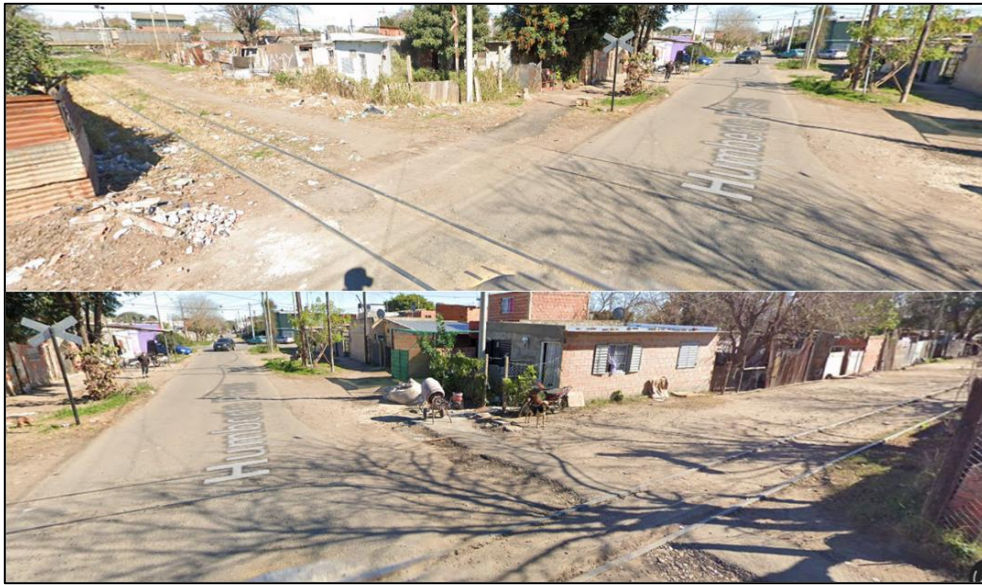
Figura 7. Vía invadida por edificaciones. Fuente: Google Maps, 2019
