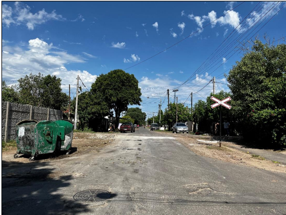
Figura 9. Presencia de Cruz de San Andrés. Visibilidad obstaculizada
